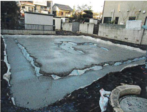
← 捨てコンクリート打設
