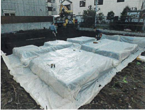
← 免震基礎工事中 土木シート敷込み
