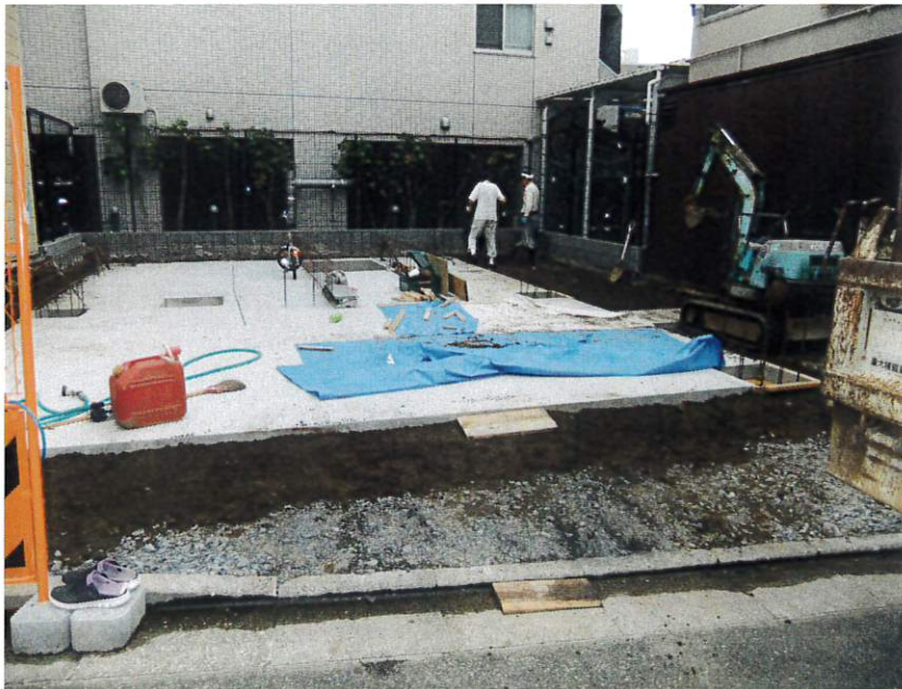
工事中の重量鉄骨の様子もご覧になれますよ。
