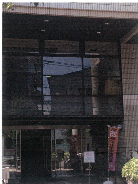
正面入口(奥野エレベータをご利用下さい)
