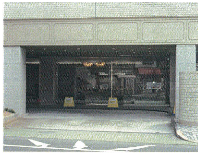
サンパール荒川正面入口
