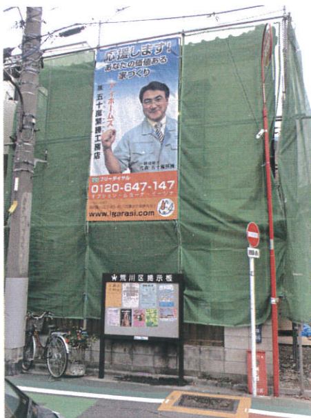
木造2階建ての耐震リフォーム中です。
