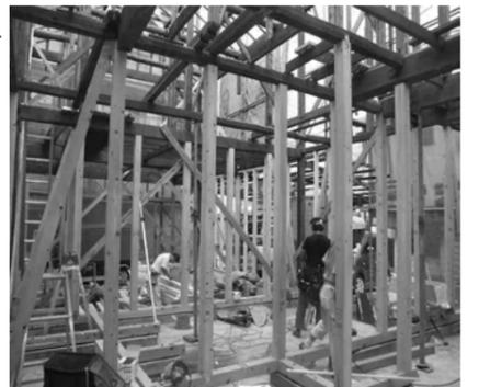
**アフター** 耐震基礎にして既存の土台・柱の悪い所は取替え、屋根も軽くし、さらに階段も登りやすくしました。2階も全面改修しました。
