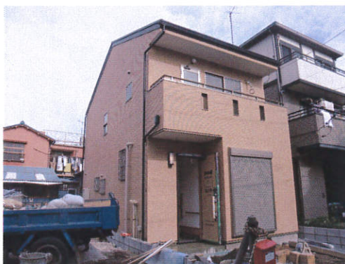
外構工事中。 見学会には立派な建物に大変身！ 是非お越しください♪
