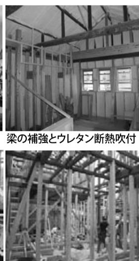
梁の補強とウレタン断熱吹付
